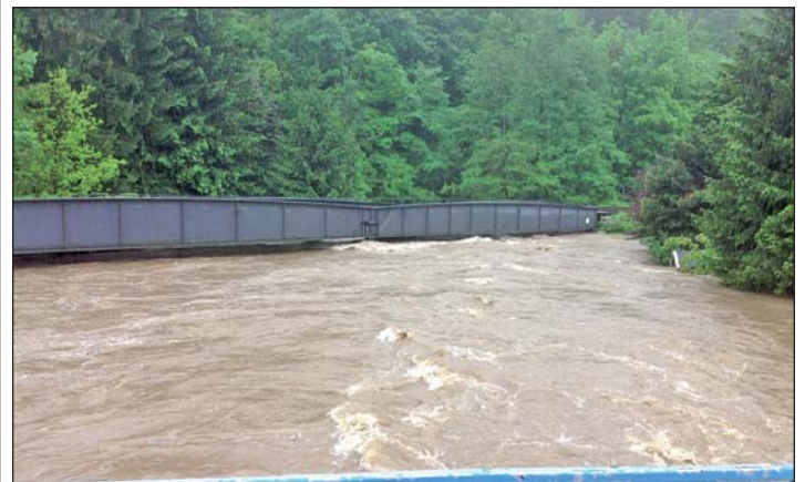
Zwönitz, Bahnbrücke Mühlweg
